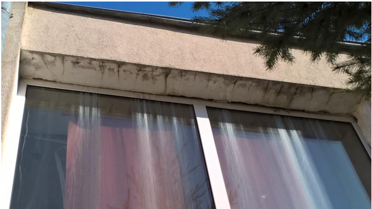
Fot.10. Widok zacieków na oknach sali gimnastycznej
