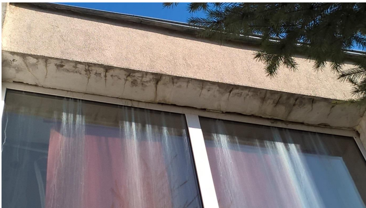
Fot.11. Widok zacieków na oknach sali gimnastycznej
